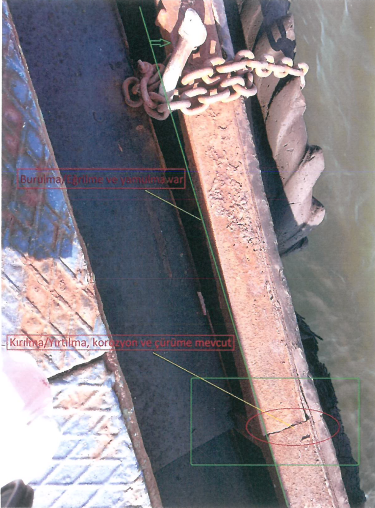
Resim.2. Konak iskelesi Karşıyaka tarafı platform usturmaçalarındaki deformasyon/kırılma ve kopmalar
